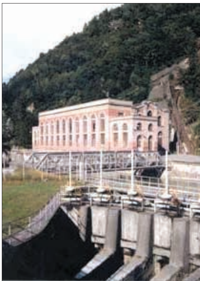
La centrale dell'Aem di Grosotto (Sondrio)
