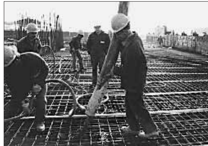
Operai al lavoro in un cantiere edile. Foto di Roberto Canò
