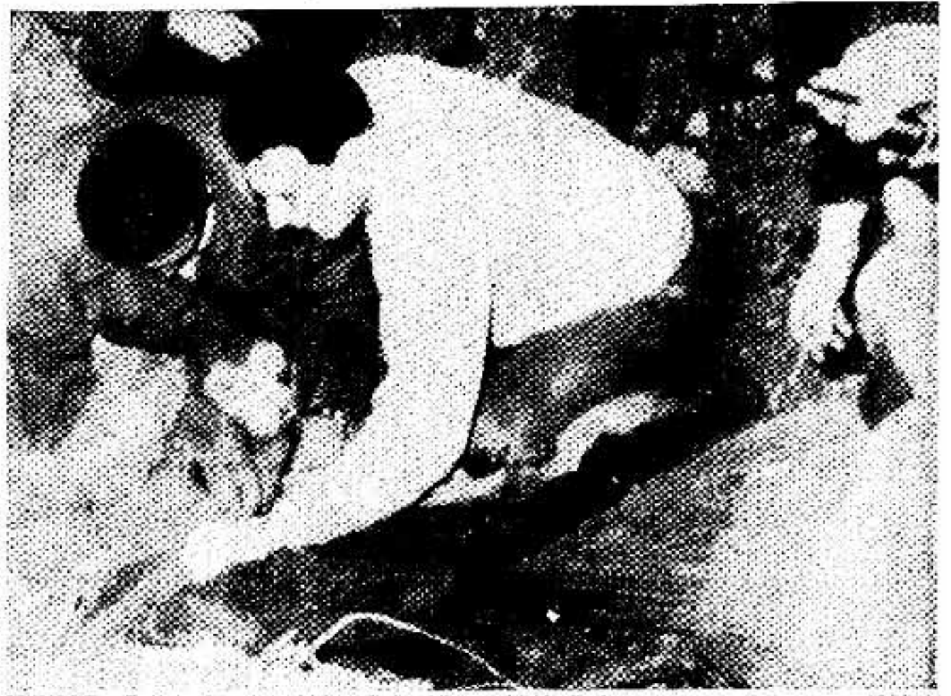
LONGARONI — Tra i bimbi che si erano rifugiati nel vano elettrico della diga. Respira sott'acqua
