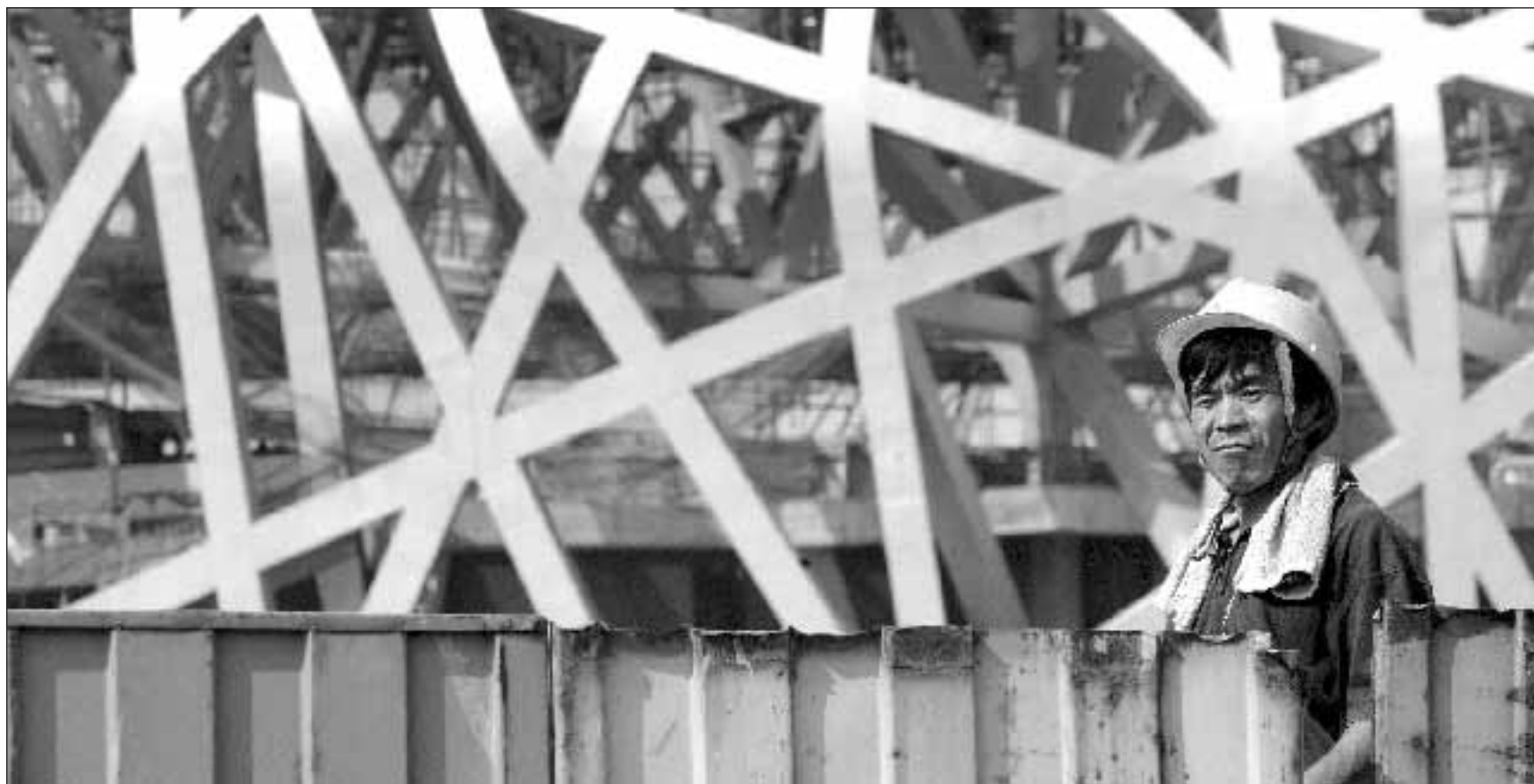
Un operaio edile impegnato nella costruzione dello stadio di Pechino; in basso dei minatori cinesi in pausa lavoroFoto Ap
