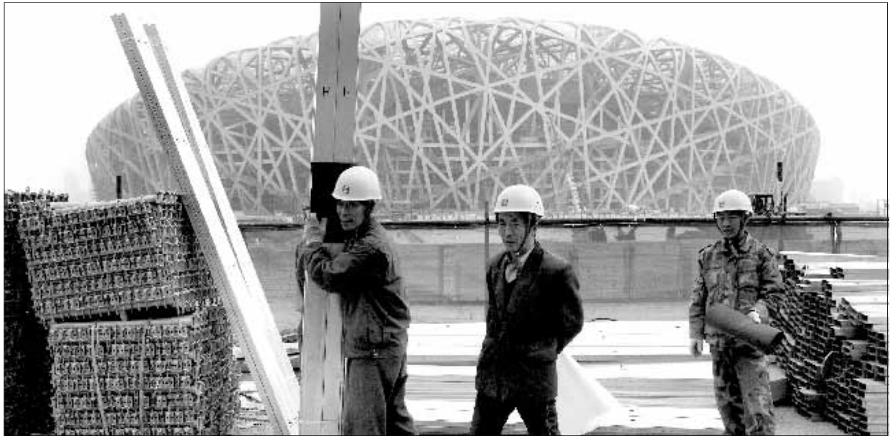
Il nuovo stadio olimpico di Pechino in fase di costruzione. Foto di Andy Wong/AP
