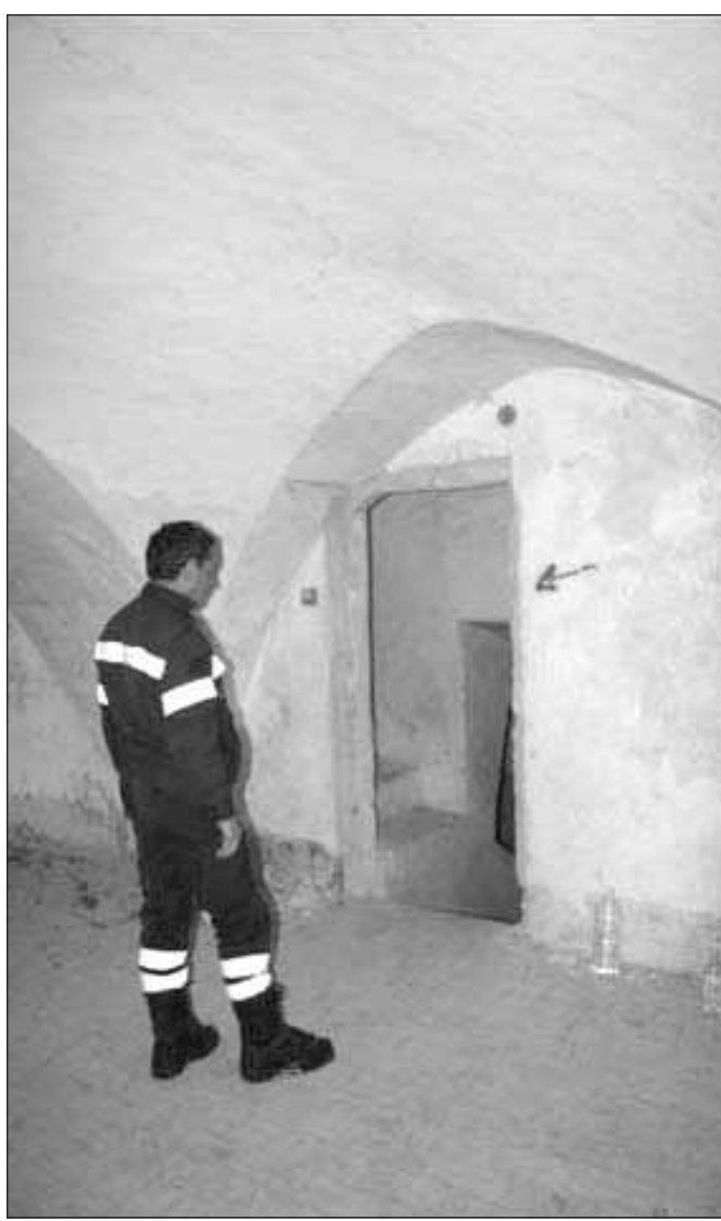
L'esterno del cunicolo che porta alla cisterna dove sono stati ritrovati i corpi dei fratellini Pappalardi. Foto di Luca Turi/Ansa
