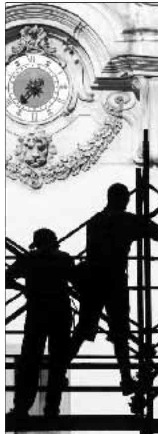
Un cantiere edile Foto Ansa
