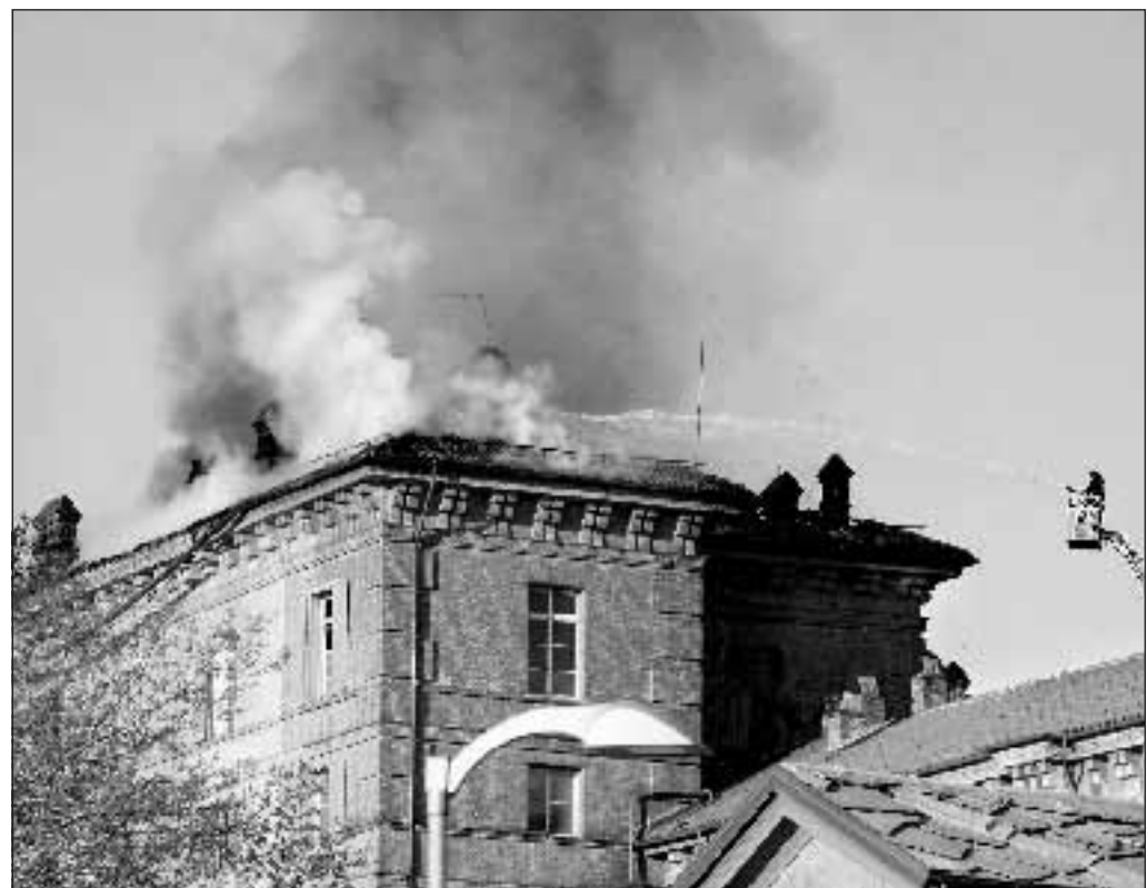
I vigili del fuoco lavorano per spegnere l'incendio nel castello di Moncalieri a Torino. Foto Di Marco/Ansa
