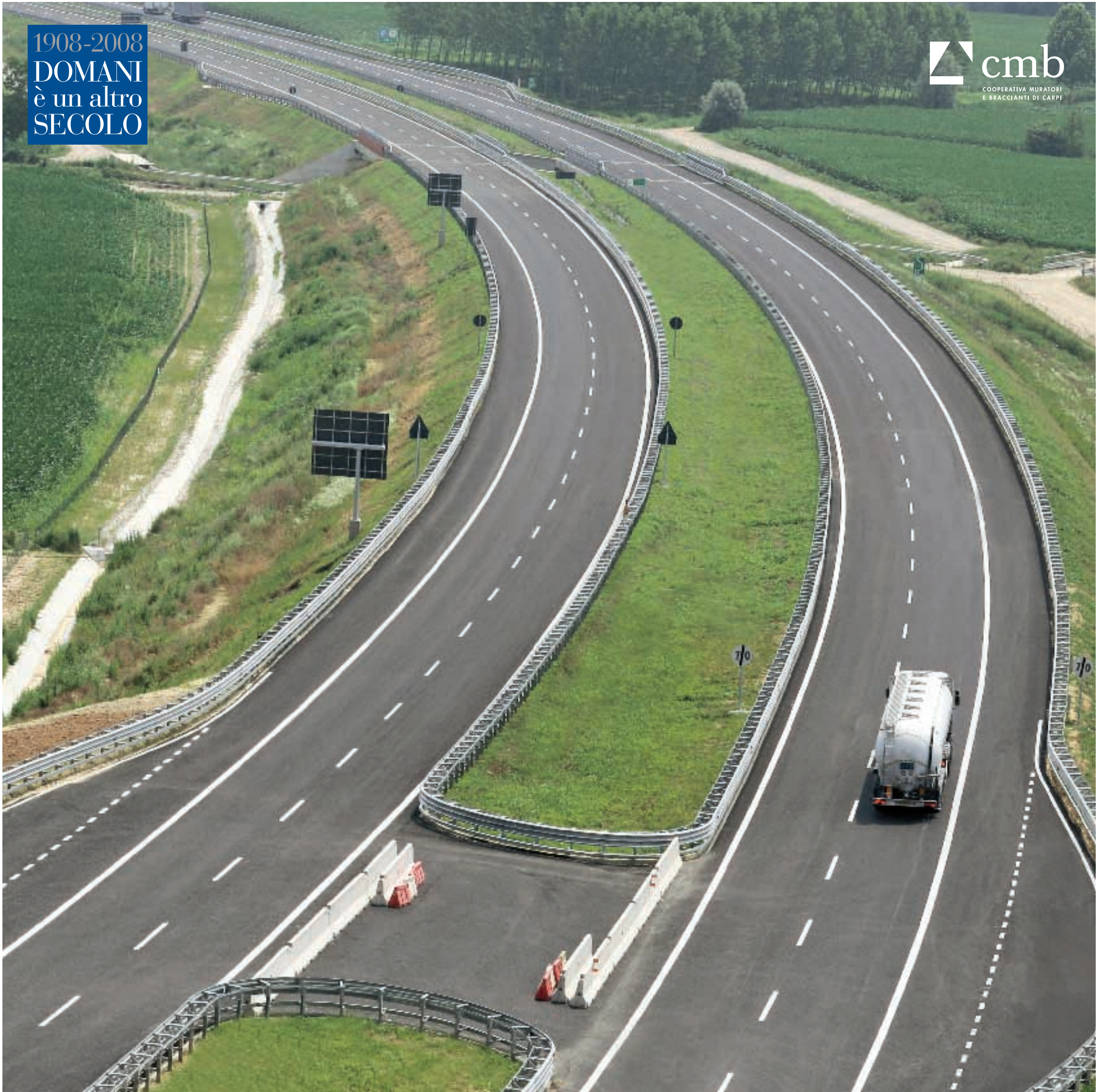
Tratto autostradale Asti-Cuneo
