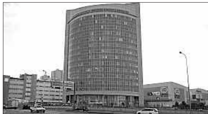
La torre Marconi della Selenia Communications di proprietà della Finmeccanica
