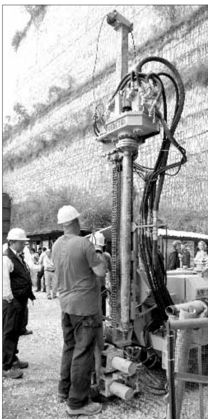
I lavori di carotaggio nella cava di Chiaiano, in alto i blocchi Foto LaPresse
