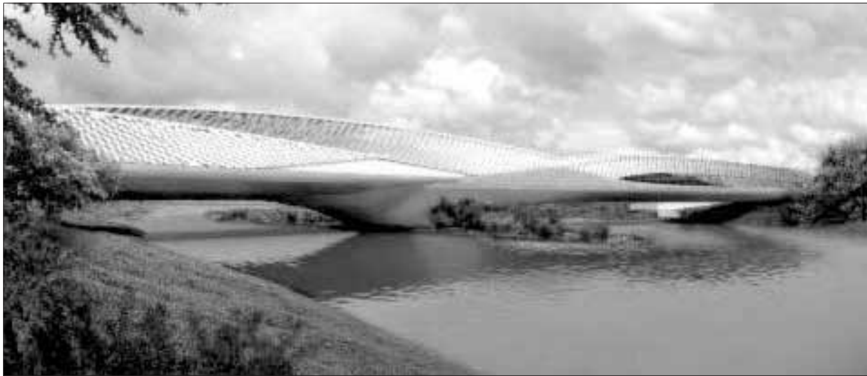
Uno dei padiglioni dell'Expo di Saragozza
