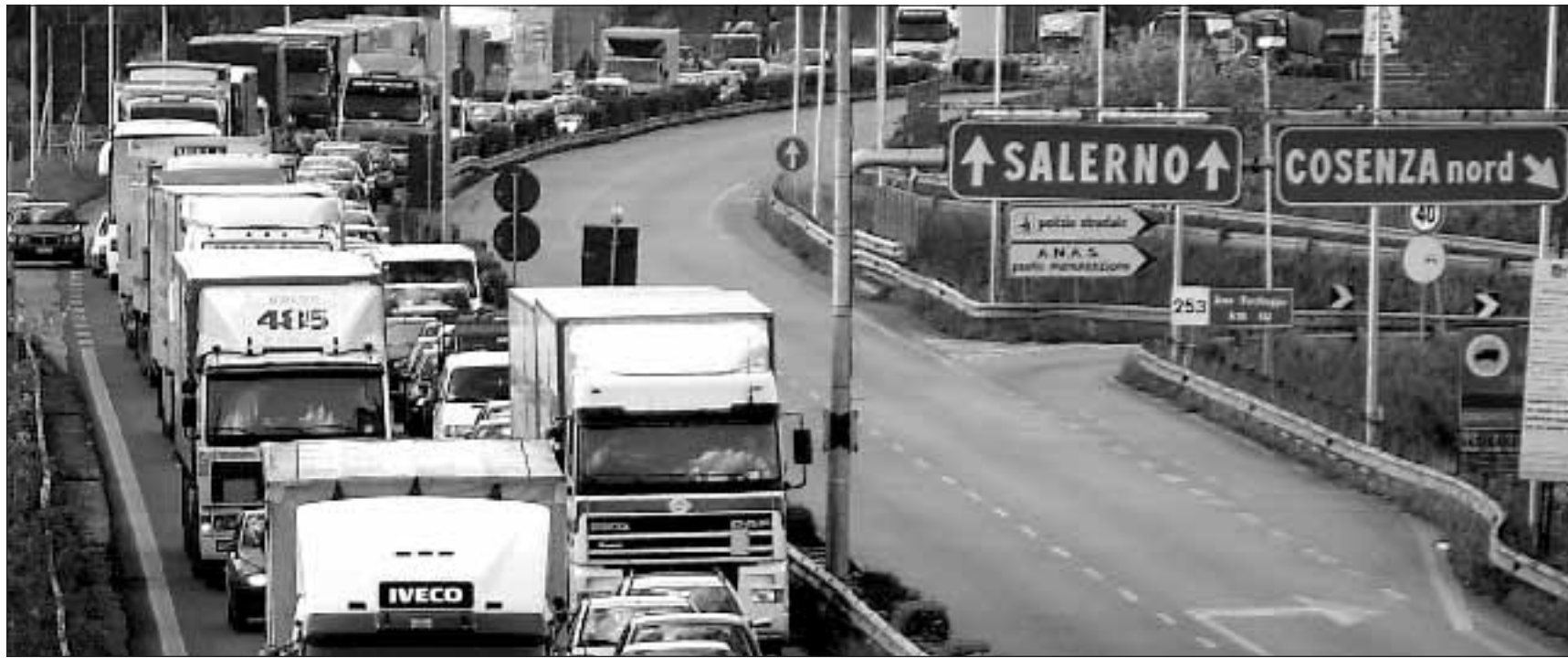
Il tratto della Salerno Reggio Calabria alla stazione di Cosenza
