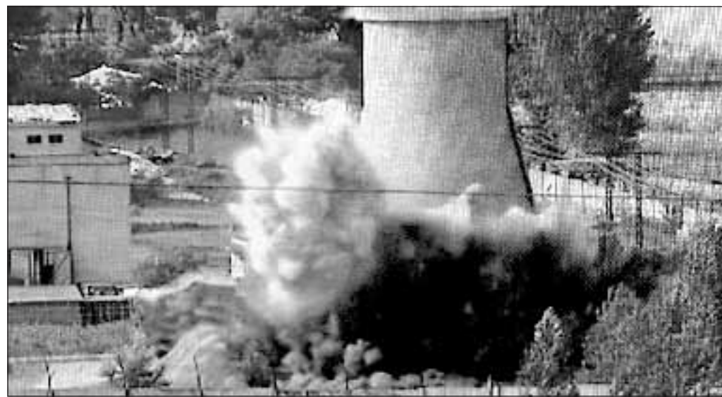
La torre di raffreddamento fatta saltare con una potente carica di esplosivo Foto Ansa
