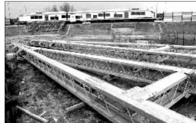
I binari del cantiere della TAV di Novara. Foto LaPresse
