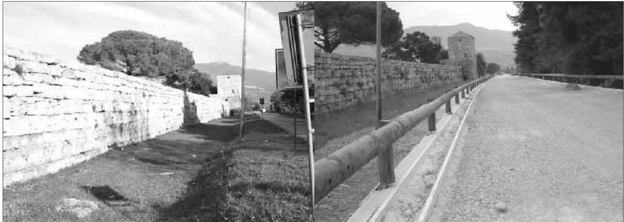
Paestum: il tratto di strada contestato lungo le mura antiche. Prima dell'intervento, e dopo in corso di realizzazione
