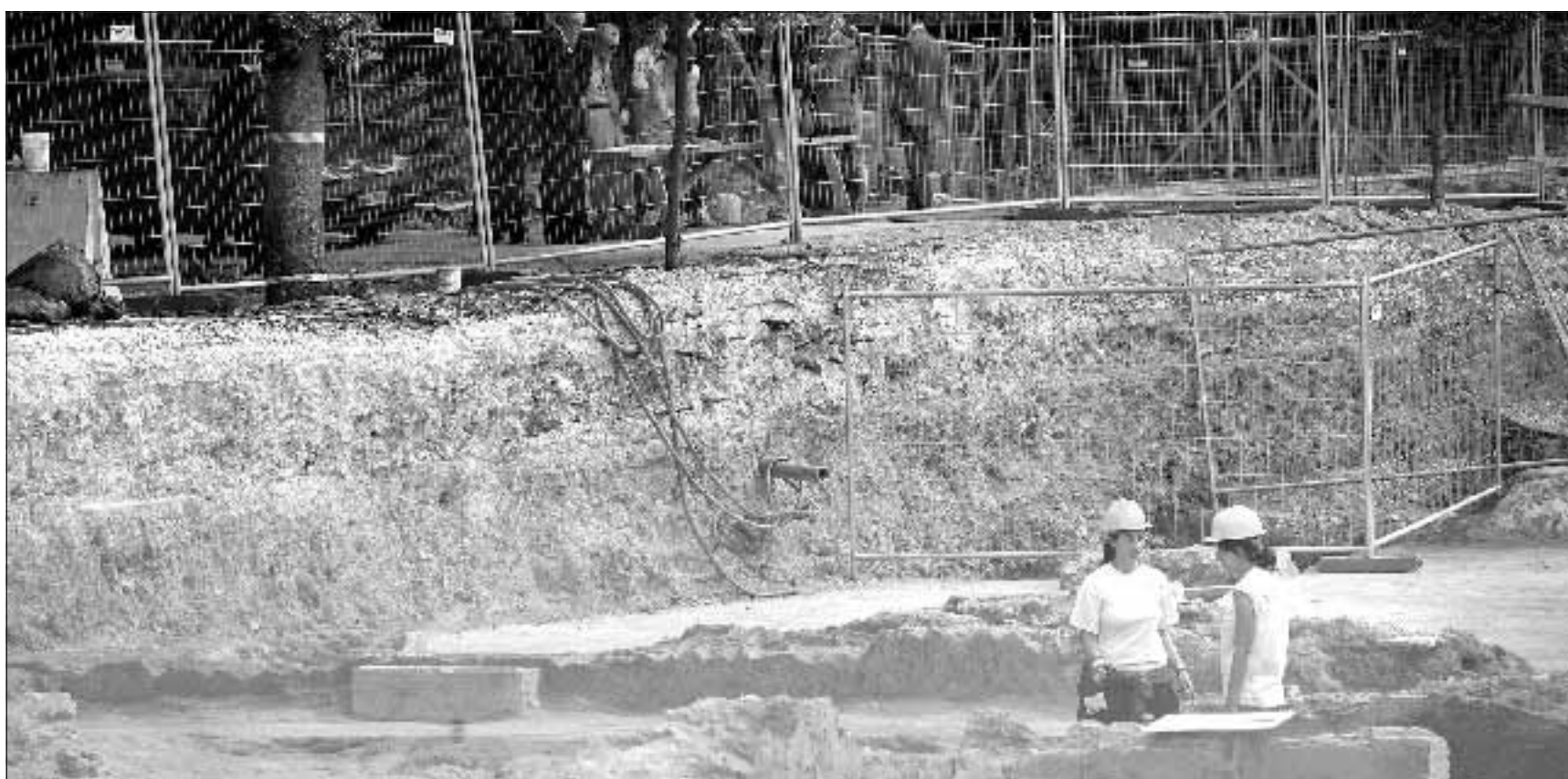
Il cantiere del parcheggio del Pincio a Roma. Foto Omniroma
