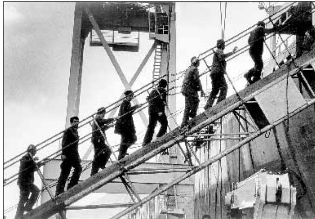
Operai al lavoro Foto Dino Fracchia
