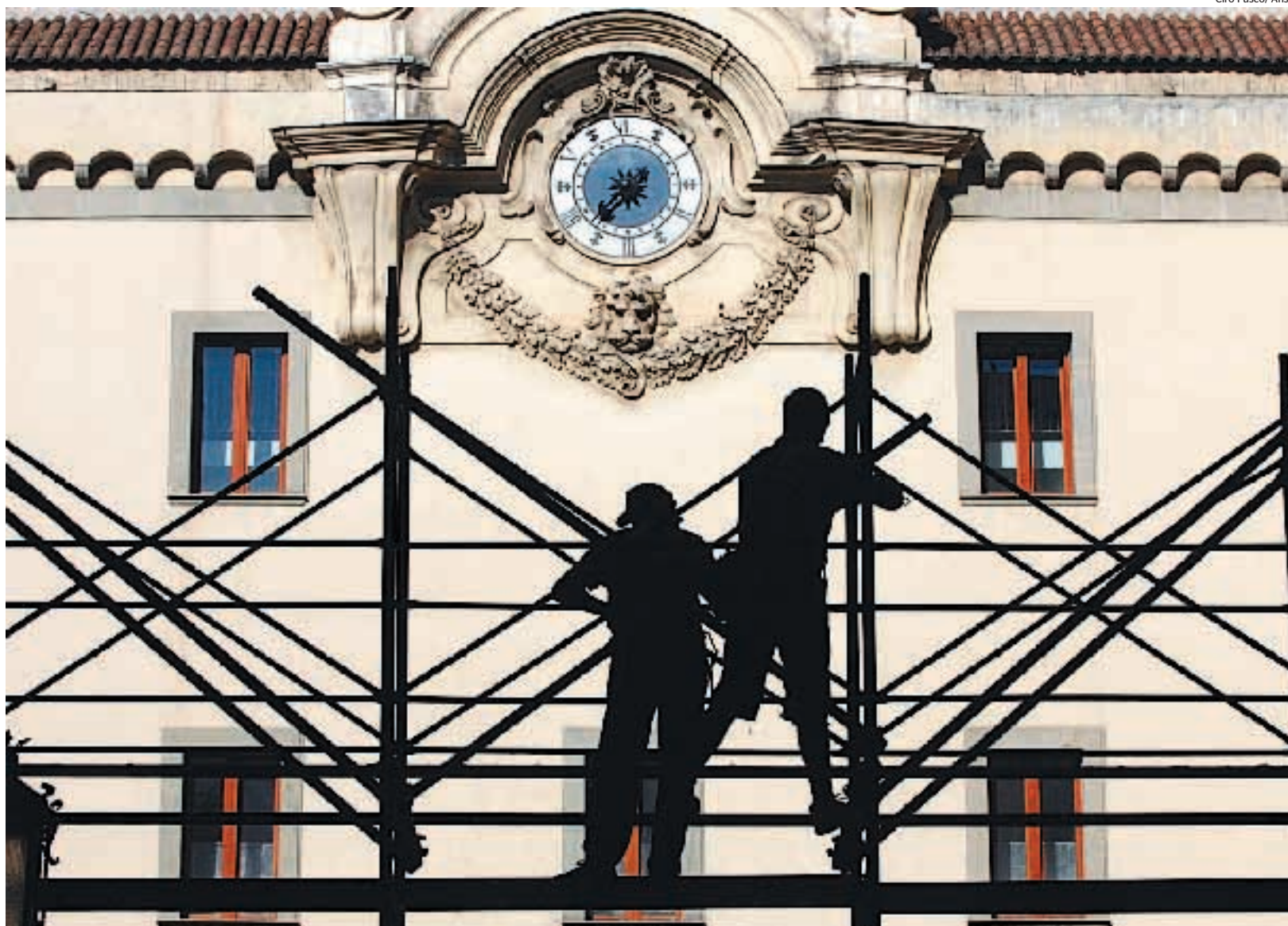
Napoli Operai a lavoro in un cantiere
