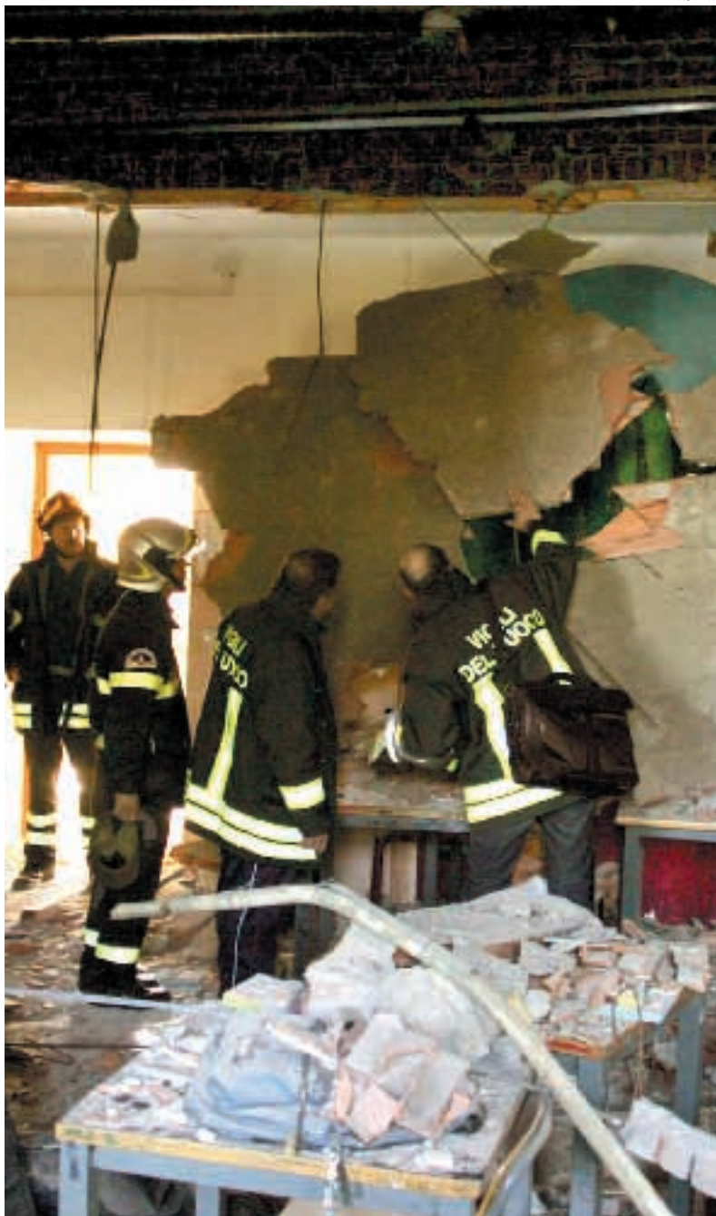
Vigili del fuoco ispezionano l'aula del liceo Darwin dopo il crollo
