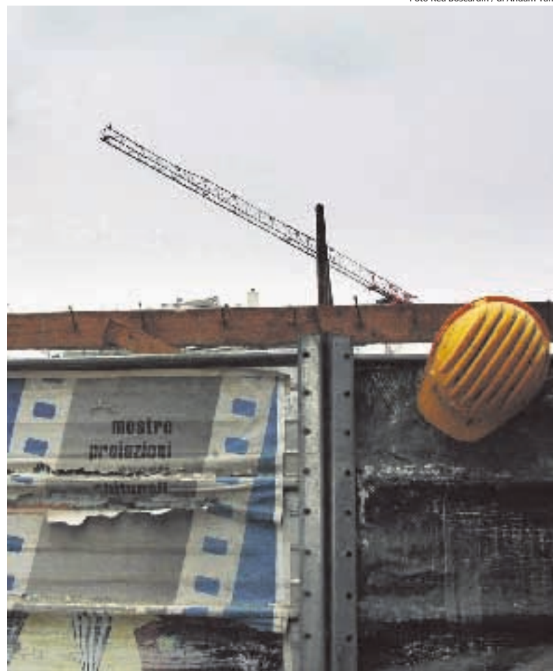
Sui ponteggi di un cantiere di Milano.
