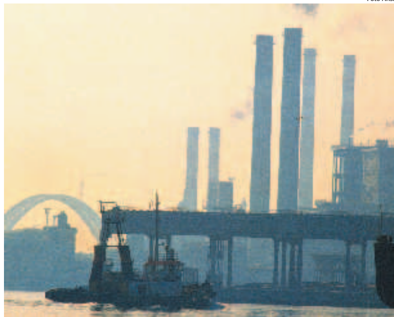
L'area industriale di Porto Marghera
