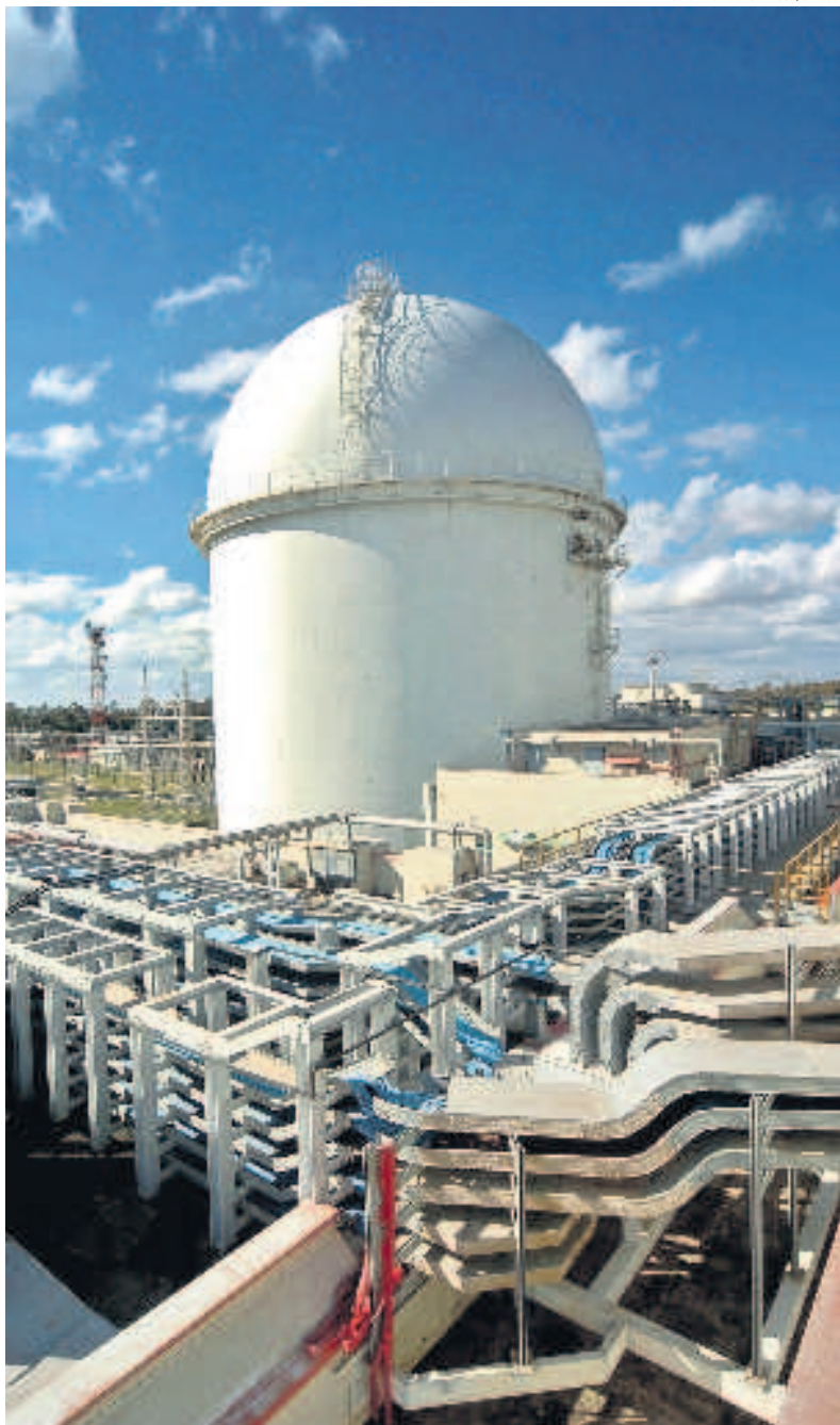
Latina, la centrale nucleare dismessa di Borgo Sabotino
