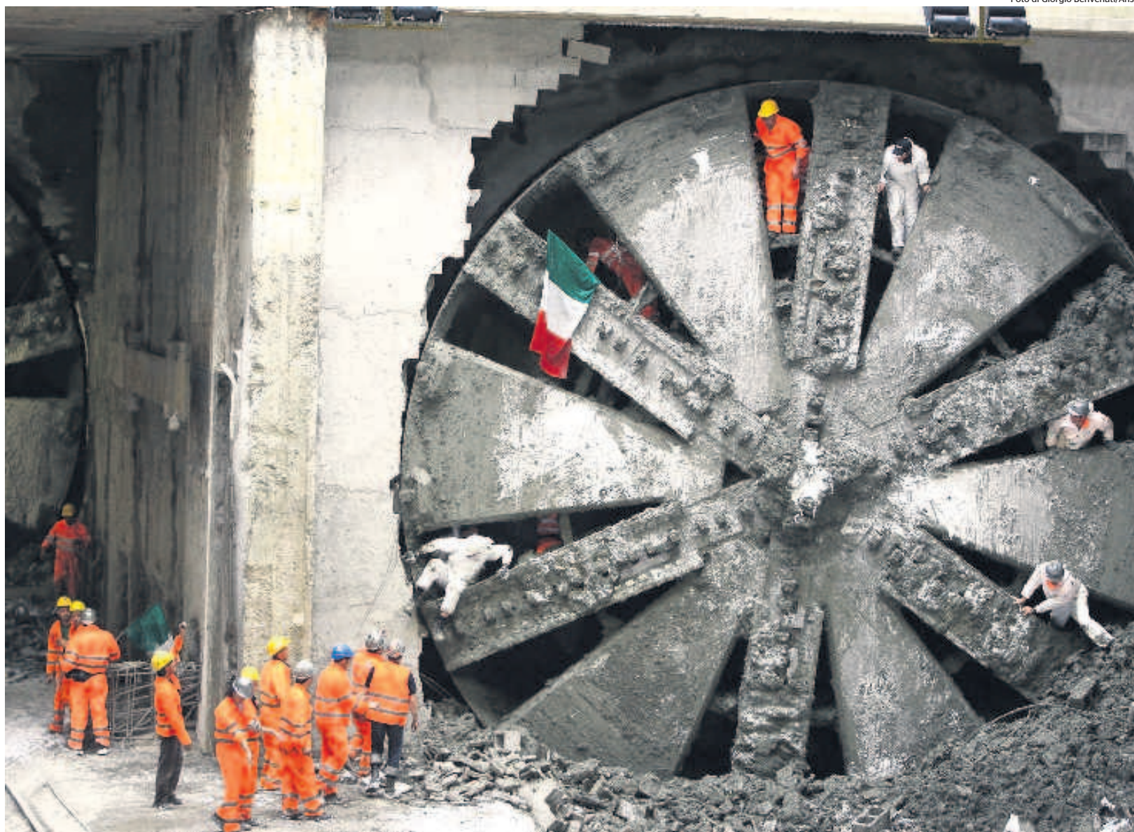
Bologna, 31 maggio 2006 gli operai festeggiano davanti alle due gigantesche frese dopo la cerimonia di abbattimento dell'ultimo diaframma in galleria per la linea ad alta velocità
