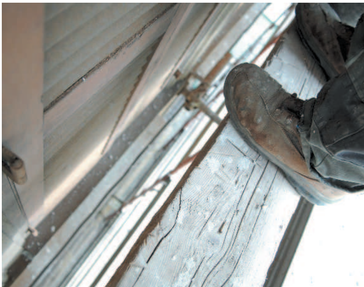
Risulta sempre alta la percentuale di incidenti sul lavoro anche mortali nei cantieri edili
