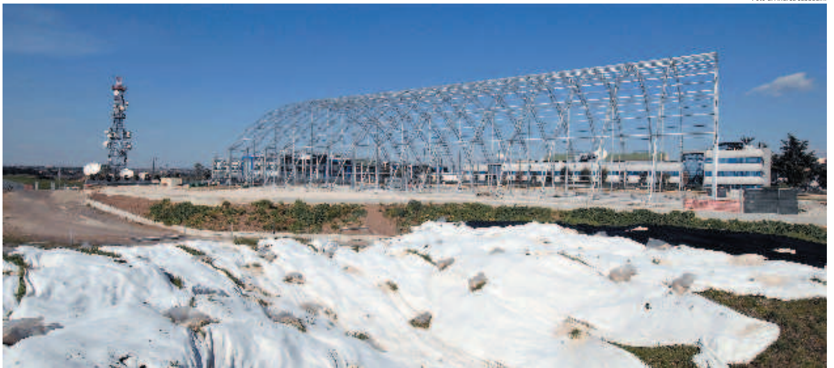
La struttura di ferro del capannone di Videotime sulla Tiburtina, a Roma
