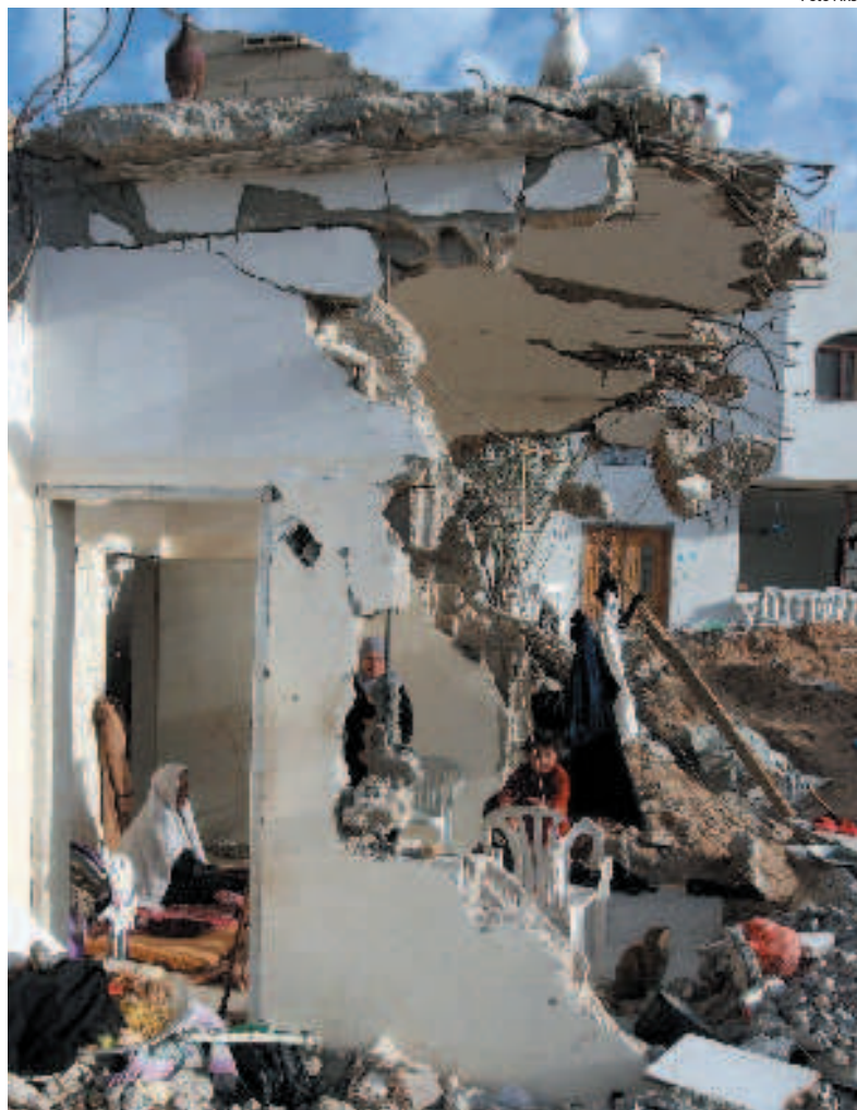
Una casa distrutta nella Striscia di Gaza durante il conflitto
