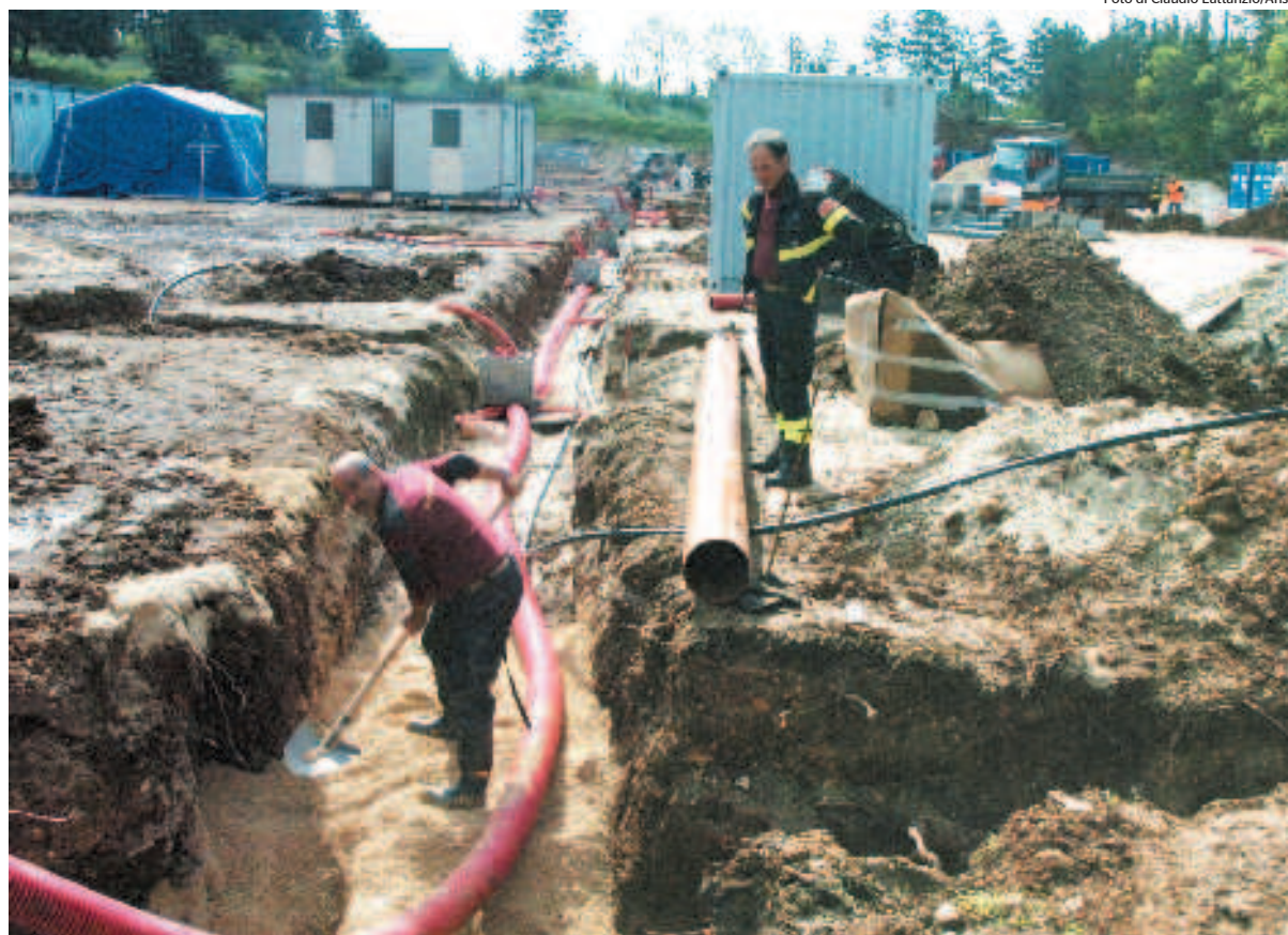
Operai al lavoro a L'Aquila
