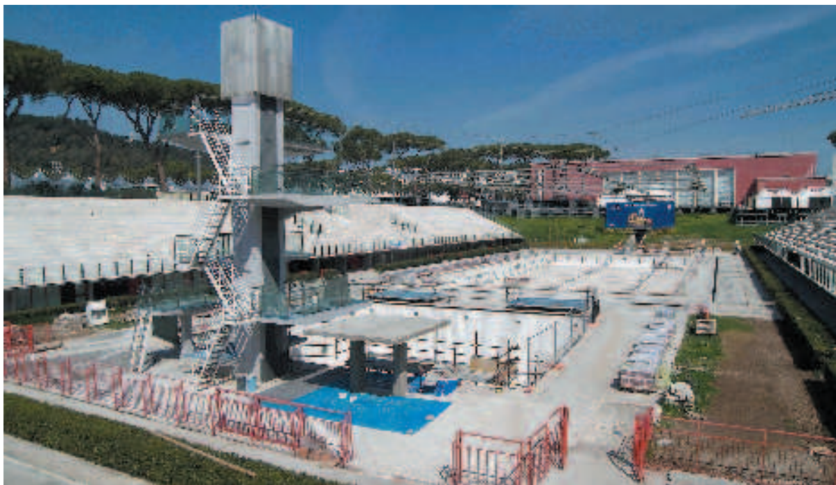
Lavori in corso per i mondiali di nuoto a Roma: la competizione iridata sarà il primo banco di prova per i nuovi vertici del Coni
