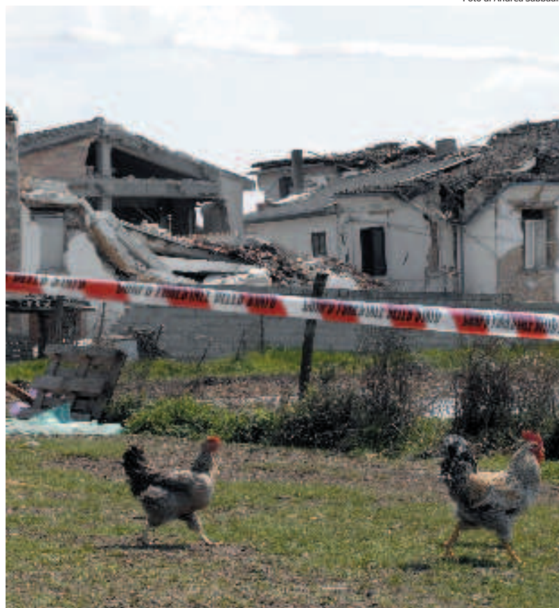
Onna Edifici distrutti dal sisma
