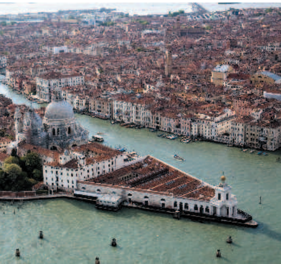
Fuori Il complesso restaurato di Punta della Dogana visto dall'alto
