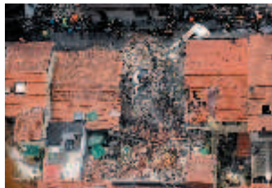
I danni provocati dall'esplosione
