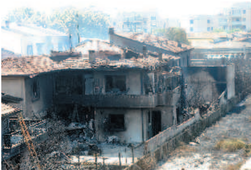
La devastazione intorno alla stazione di Viareggio
