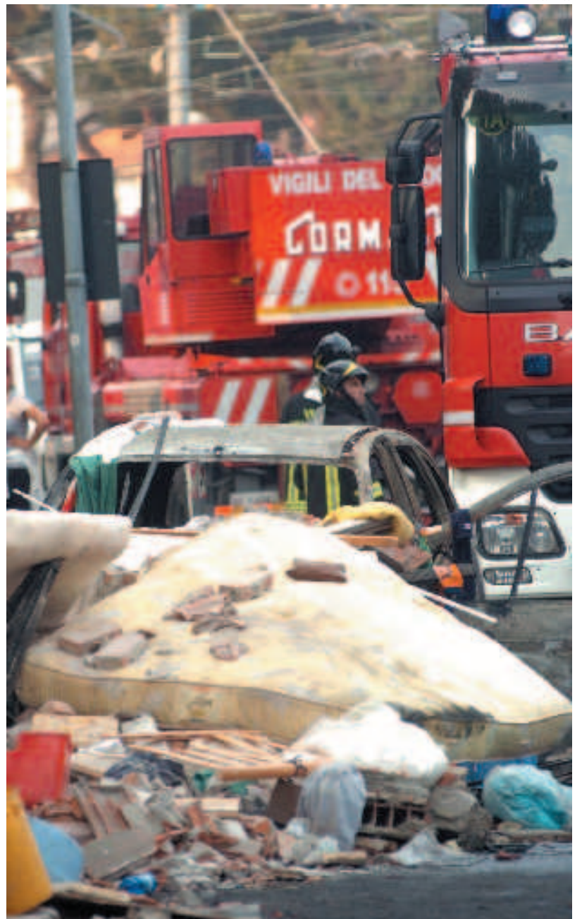
I soccorritori al lavoro tra le abitazioni crollate
