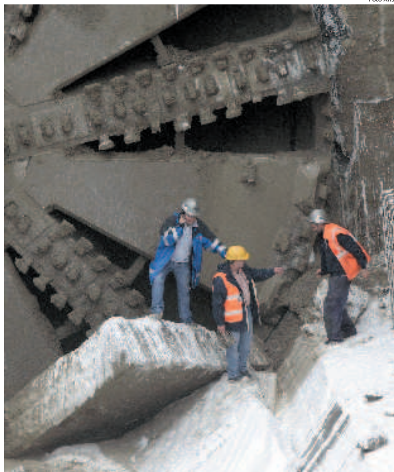
Alcuni operai al lavoro dopo l'uscita della «talpa meccanica»
