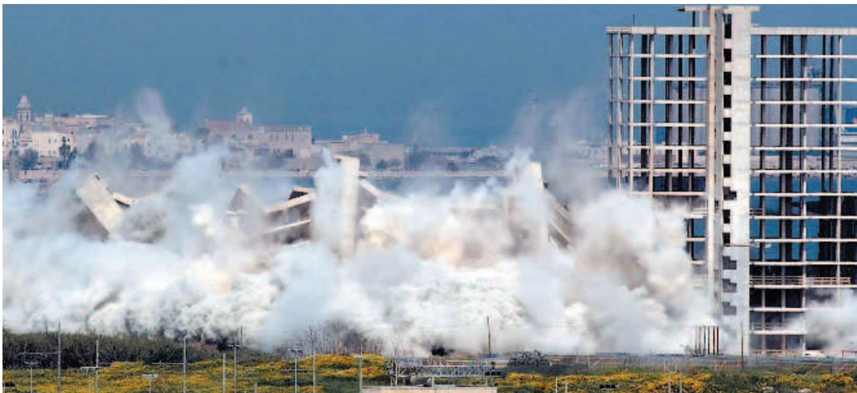
Fumo e polvere per l'implosione di Punta Perotti, «storico» abbattimento sul lungomare di Bari avvenuto in tre fasi nei giorni 2, 23 e 24 aprile 2006
