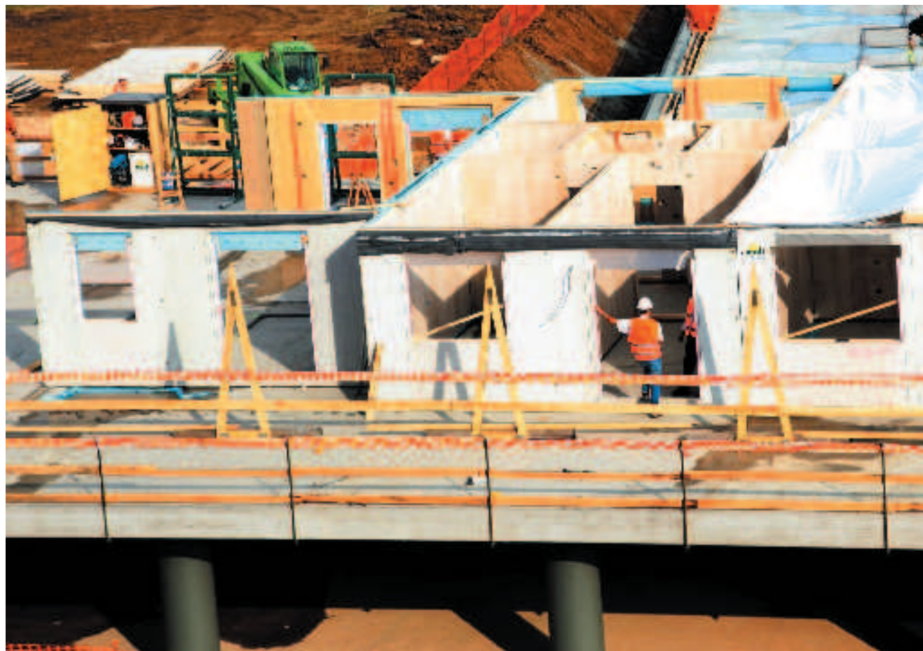
Lavori in corso: i 35 appartamenti di Cese di Preturo
