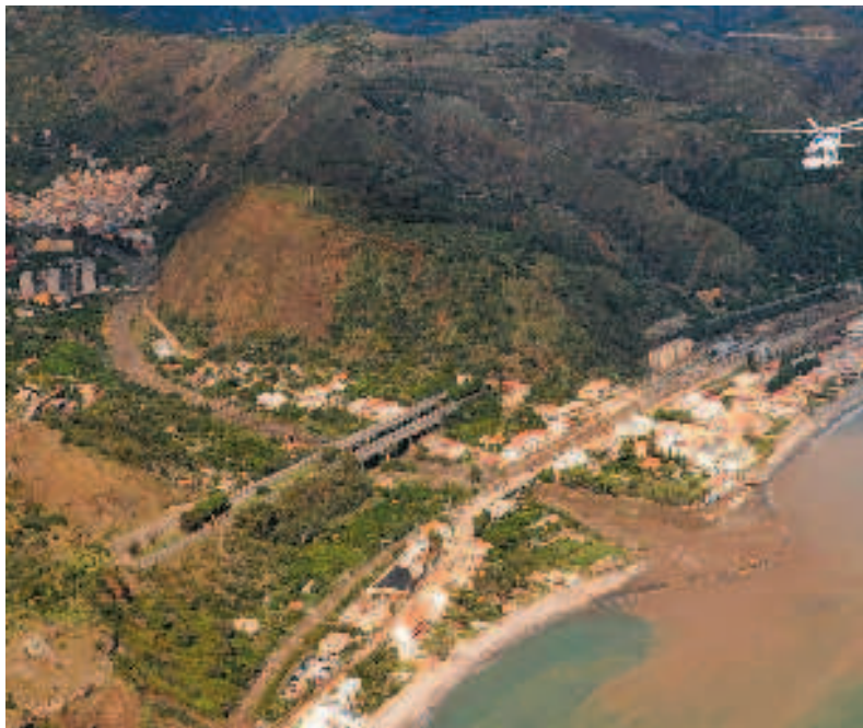
Le devastazioni provocate dalla frana viste dall'alto
