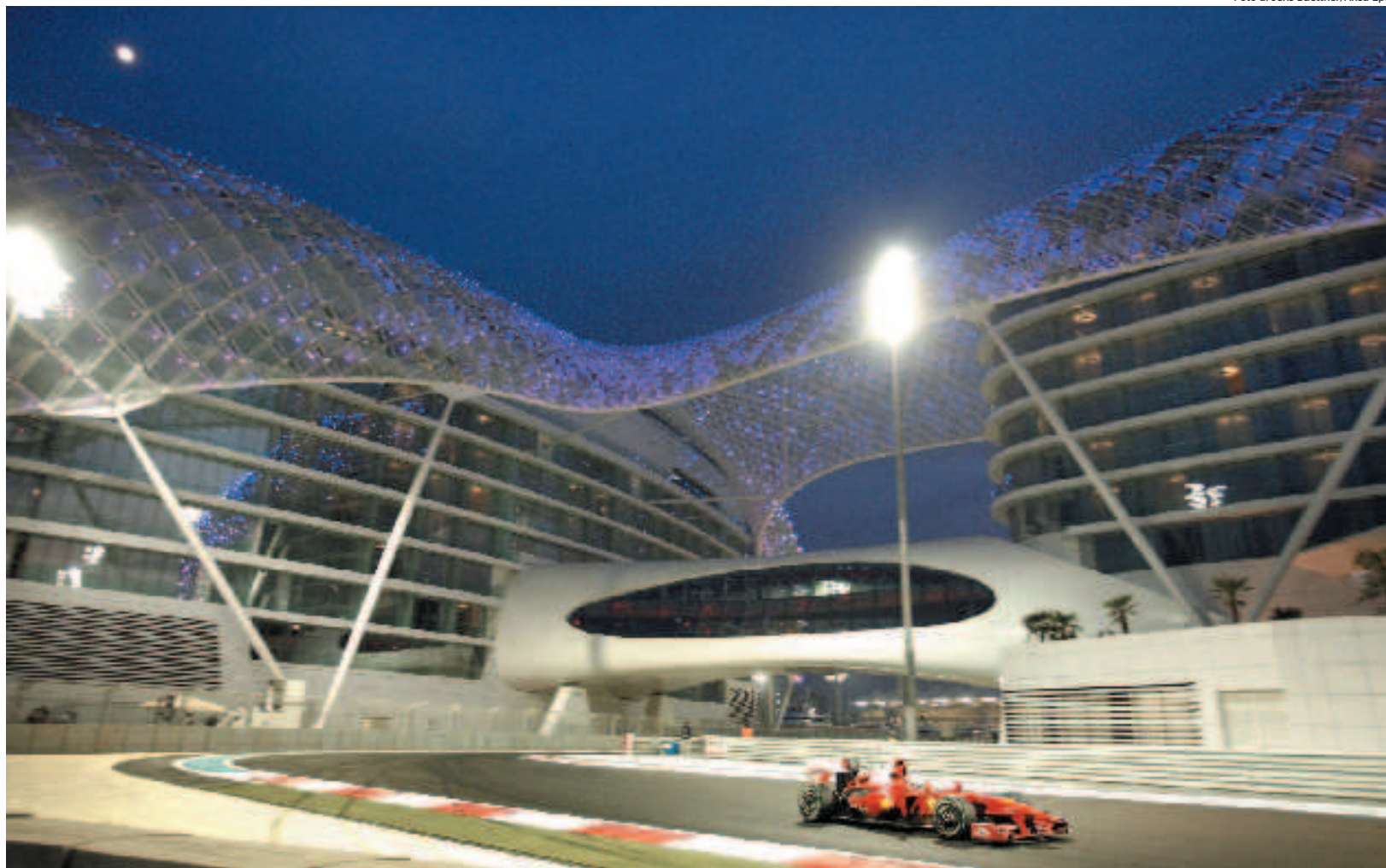
Il circuito di Yas Marina, a Abu Dhabi, passa sotto un hotel a 7 stelle da cui si può assistere al Gran premio
