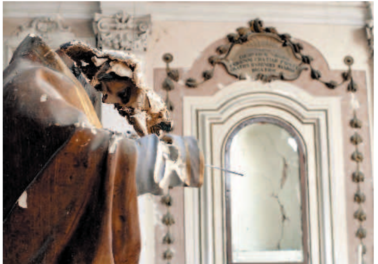
Onna: i danni provocati dal terremoto alla chiesa
