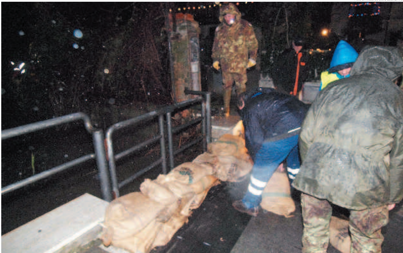
Il posizionamento dei sacchi di sabbia sull'argine del lago. I comuni di Viareggio, Camaiore e Massarosa stanno preparando i piani di evacuazione in previsione dell'ondata di maltempo
