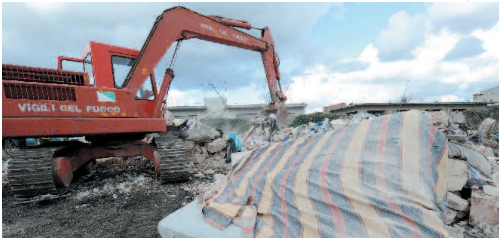
Demolizioni un corso a Rosarno
