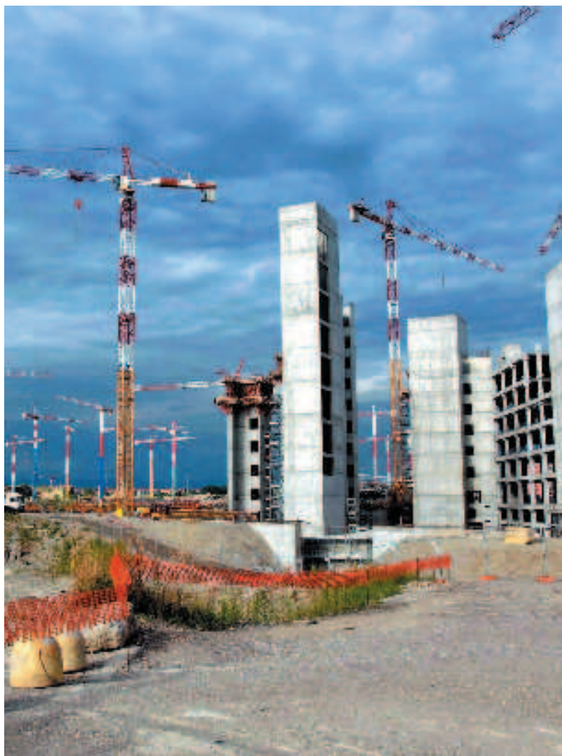
La costruzione del nuovo quartiere Santa Giulia nell'ambito dei lavori per Expo 2015
