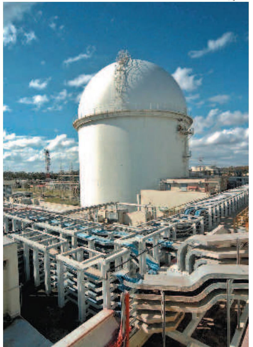
Ex centrale nucleare di Latina Borgo Sabotino impianto Cirene
