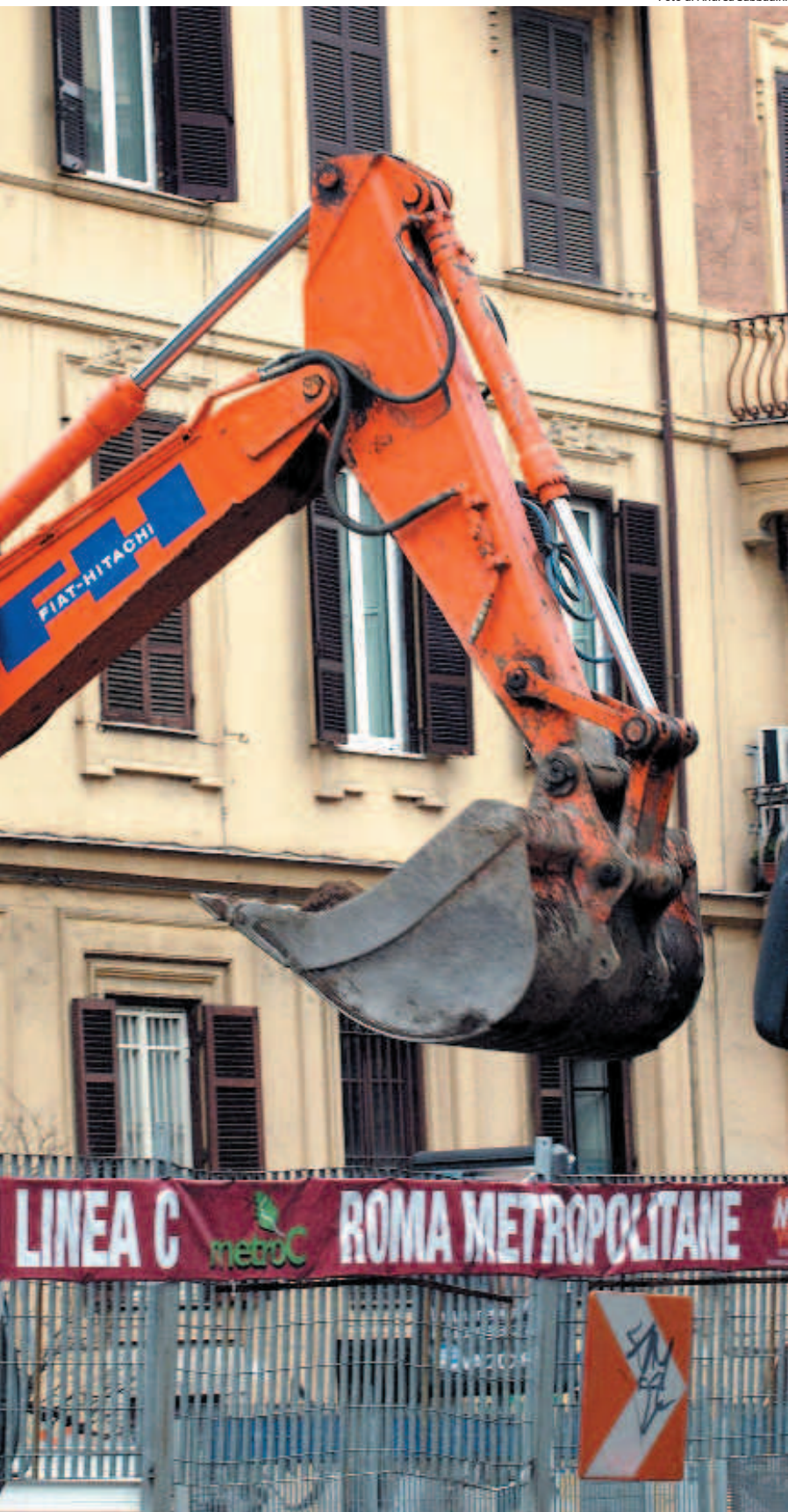
Roma Lavori in corso per la Metro C
