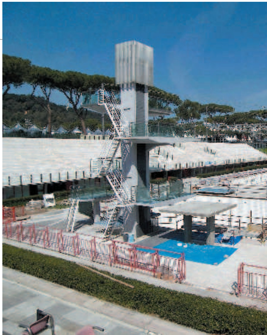
I cantieri delle grandi piscine del Foro italoico a Roma
