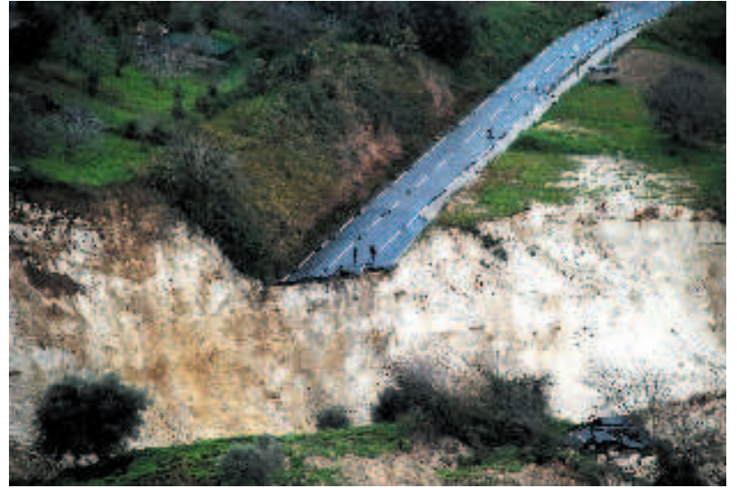
La frana che ha colpito il comune di Maierato oggi 16 febbraio 2010
