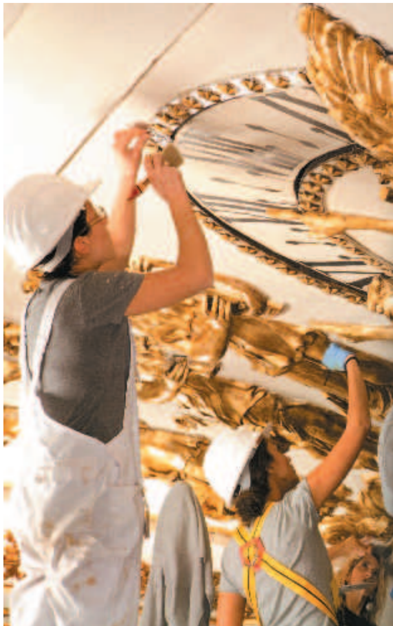
Restauratori al lavoro
