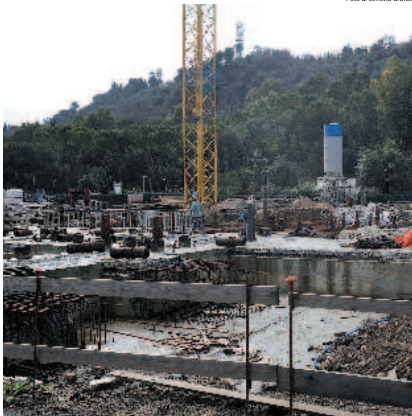
Il cantiere al Foro Italico
