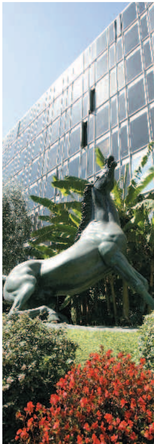
La sede Rai di viale Mazzini
